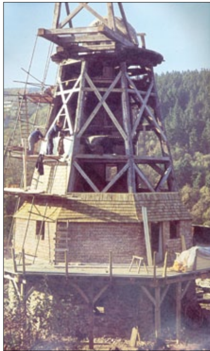
Als erstes Gebäude des Freilichtmuseums wird die Windmühle errichtet (Foto: LWL)
